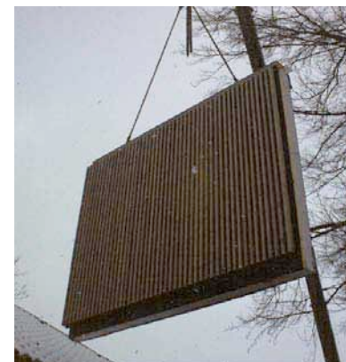
Montage Fassadenelemente
